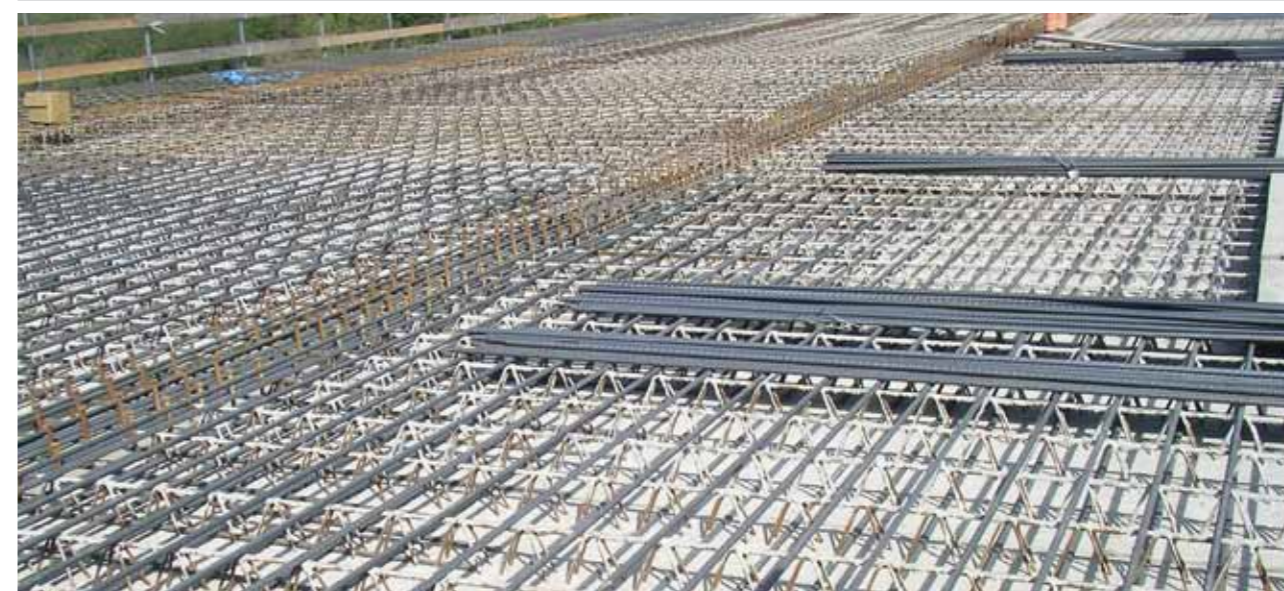
Lastra autoportante impiegata per solaio bidimensionale massiccio
